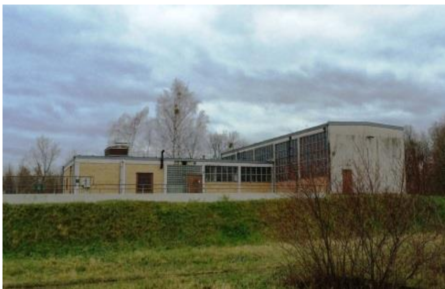
Wasserwerk Eggenstein-Leopoldshafen im Bestand
