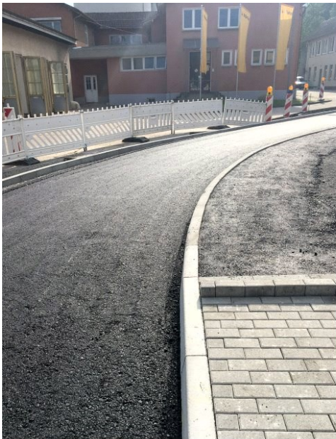
Radwegführung durch das Zementwerk Märker
