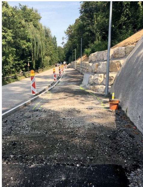
Radwegführung entlang der Oskar-Miller-Straße, Hangsicherung durch Spritzbetonmauer und Blocksteinmauer
